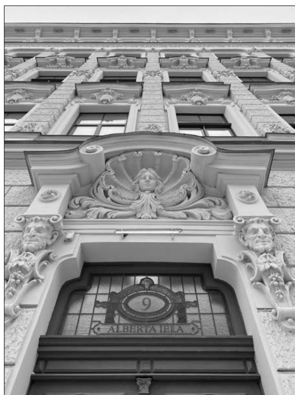
Na zdjęciu: Ulica Alberta 9, architekt Eizēns Laube. Fot. Jarosław Sidorkiewicz
